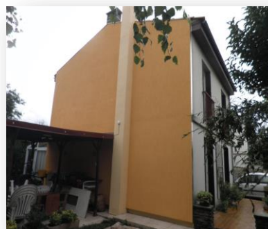
Isolation de la façade nord
