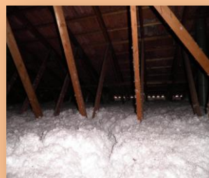
Insufflation de 30 cm de ouate de cellulose
